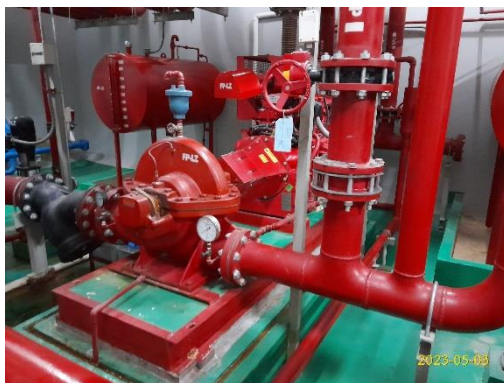
เครื่องสูบน้ำดับเพลิงชุด Low Zone
