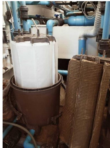
พนักงานขณะทำความสะอาดระบบกรองน้ำสระว่ายน้ำ
