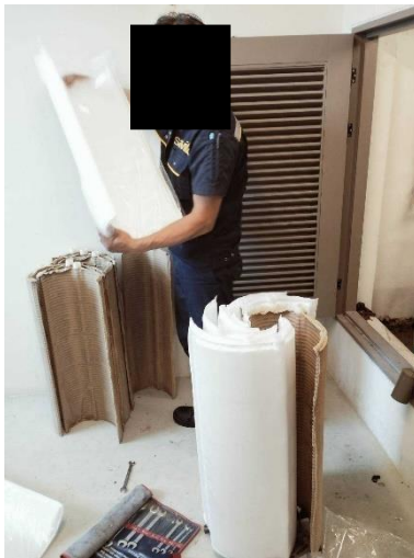
พนักงานขณะทำความสะอาดระบบกรองน้ำสระว่ายน้ำ
