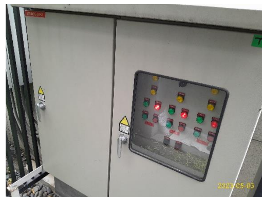
แผงควบคุมเครื่องสูบน้ำบ่อท่ว่งน้ำ
