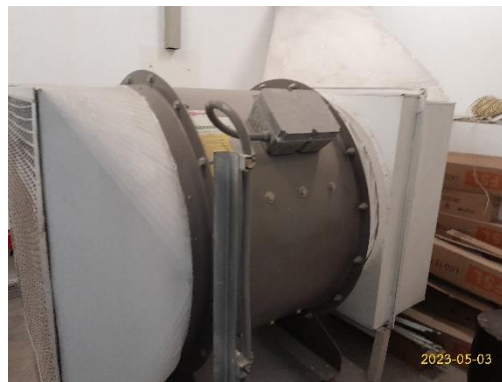
ระบบระบายอากาศพื้นที่จอดรถ (ใต้ดิน-ชั้น 2-4)
